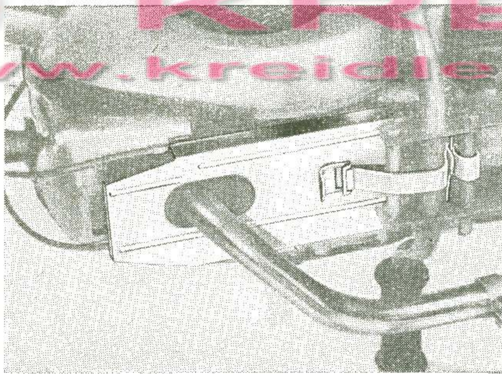
Fig. 35: Blindagem dos cabos
